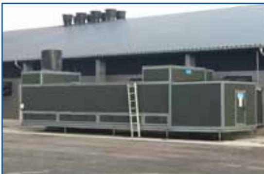
**Figura 2.7:** Disposição típica de um sistema de aquecimento em todo o aviário (1.000 pintos).
